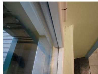
Figura 8.5 - Particolare di un infisso
