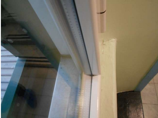
Figura 4.5 - Particolare dei serramenti – dettaglio angolo vetro – aule
