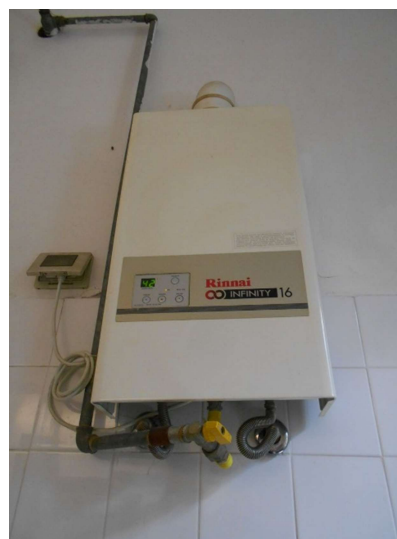
Figura 4.12 – Boiler elettrico (a sinistra) e scaldacqua istantaneo a gas naturale (a destra)
