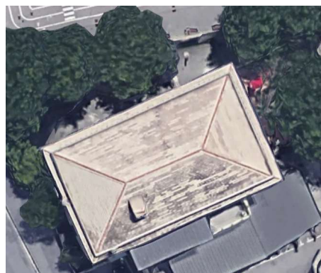
Figura 8.12 - Particolare della copertura dove installare l'impianto (fonte: Google Maps)
