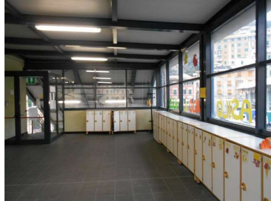
Figura 4.6 - Particolare dei serramenti – veranda chiusa
