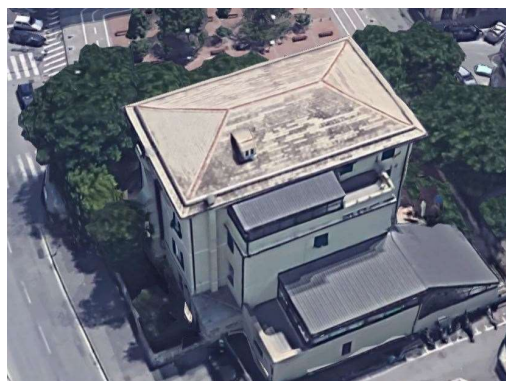
Figura 8.3 - Particolare della copertura (fonte: Google Maps)
