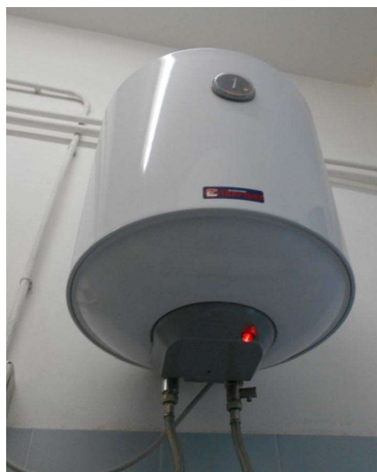
Figura 4.12 – Boiler elettrico (a sinistra) e scaldacqua istantaneo a gas naturale (a destra)
