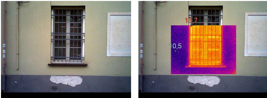
Figura 4.7 – Rilievo termografico dei serramenti
