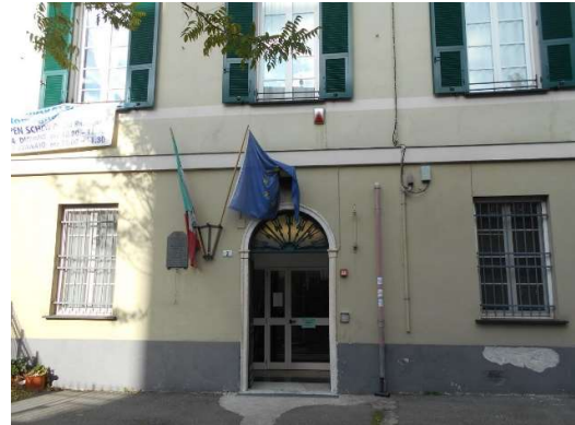
Figura 0.1 - Vista della facciata [esposta a Nord-Ovest]
